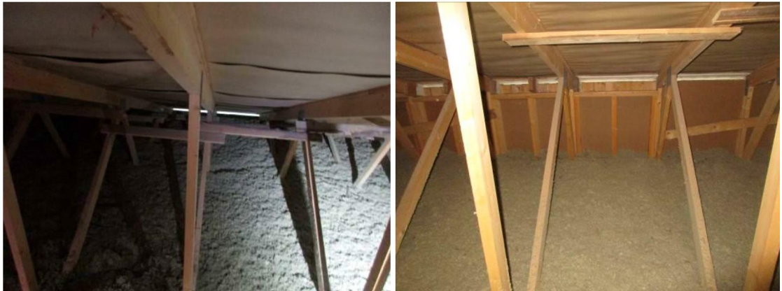
Kuvat 34 ja 35. Toiselta räystäältä puuttui tuulenhajaimet. Toisella räystäällä seinälevyit nousivat reilusti eristepintaa korkeammalle, jolloin tuulenhajaimia ei tarvita.
