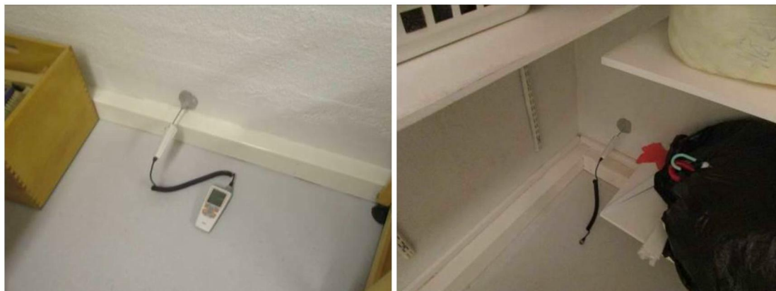
Kuvat 41 ja 42. Maanvastaisten ulkoseinärakenteiden olosuhdemittaukset tiloissa 0.3 ja 0.10.
