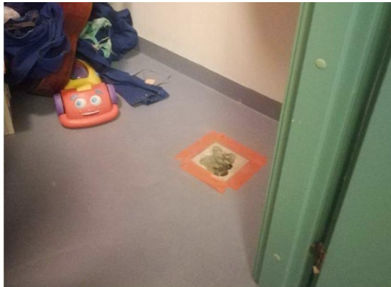
Kuva 12. Välipohjarakenteen rakenneavauskohta varastotilan 1.5 lattiasa.
