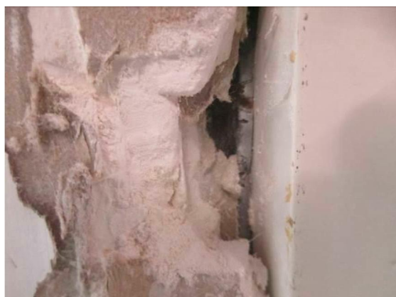
Kuva 16. Höyrynsulkumuovi on tuotu ikkunakarmia vasten, mutta sitä ei ole kiinnitetty karmiin.
