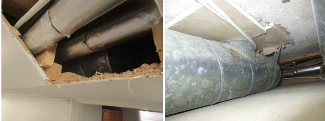
Kuvat 3 ja 4. Käytävän 0.2 katon kotelorakennetta tarkastettiin vanhasta tarkastusluukusta.
