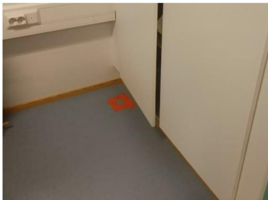
Kuva 11. Alapohjarakenteen rakenneavauskohta toimistotilan 1.12 nurkassa.
