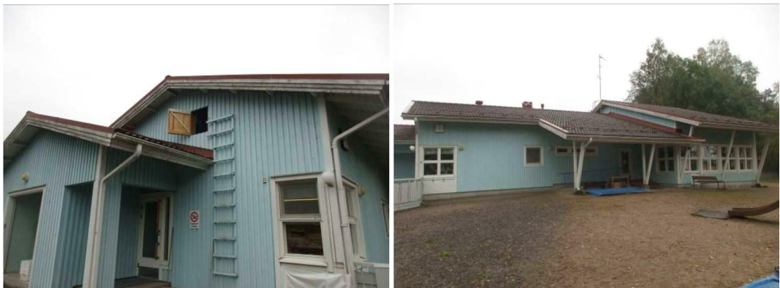
Kuvat 32 ja 33. Yläpohjatilan kulkuluukku rakennuksen päädyssä. Yläpohjatilassa pääsi kulkemaan ainoastaan ensimmäisessä lohkossa vesikaton porrastuksen kohdalle.
